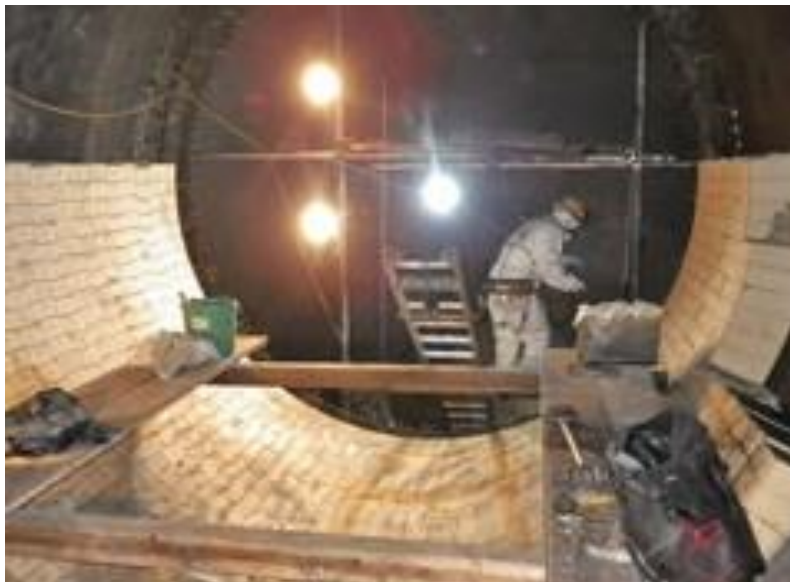
耐火れんが施工風景
